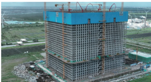
图 4 Energy Vault 与中国天楹合作项目建设图 [21-22]
