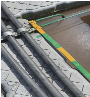
图 7 镀锌扁钢刷漆使用
