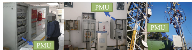
图7 同步相量监测安装示例
