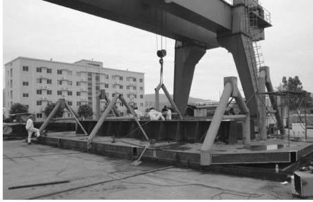
图3 滑轨架焊接完毕
