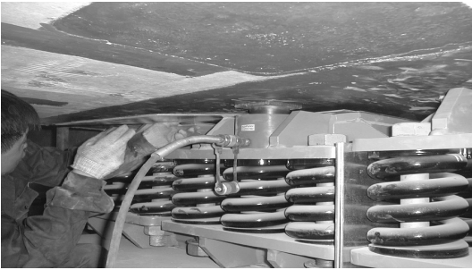
图2 利用弹性基础进行机组的对中与调平
