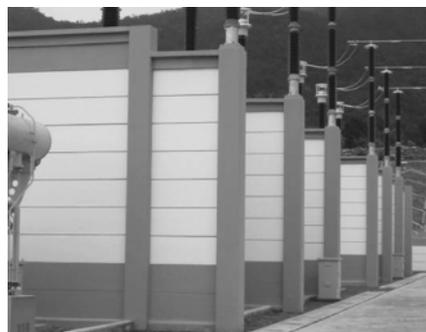
图 3 变电站装配式防火墙
