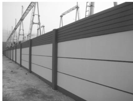
图 2 变电站装配式围墙
