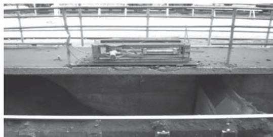
图 3 液压自动开门机构
