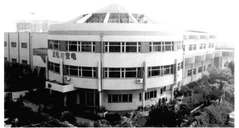
图 3 北京左安门 220 kV 变电站 Fig. 3 Zuo Anmen 220 kV Indoor Substation in Beijing
