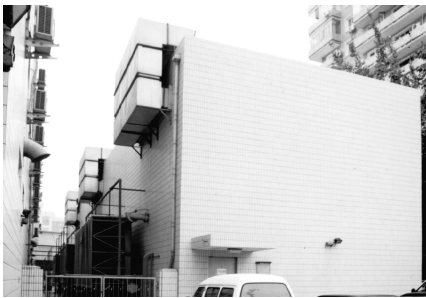
图 1 北京某户内 110 kV 变电站示例一 Fig. 1 A 110 kV Indoor Substation in Beijing
