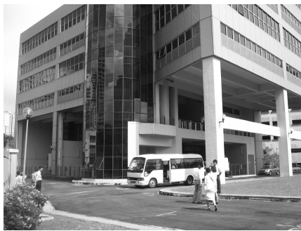
图 5 新加坡 275 kV 变电站
