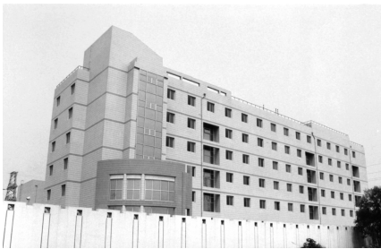
图 2 北京某户内 110 kV 变电站示例二 Fig. 2 Another 110 kV Indoor Substation in Beijing
