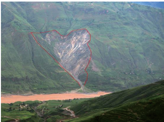
图 12 崩塌现场照片 Fig. 12 Collapse Contour Features
