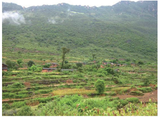
图7 滑坡后缘(现场照片)
