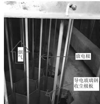
图3 管式湿式电除尘器结构
