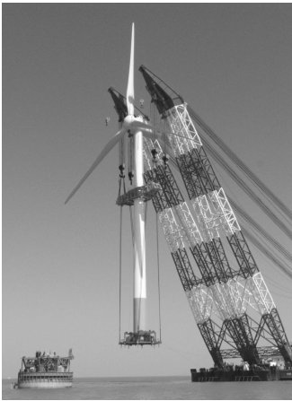
图2 海上风电机组整体吊装方案
