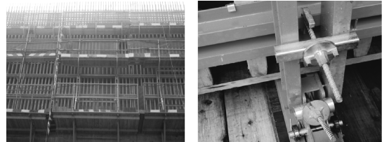
(a) 模板安装
