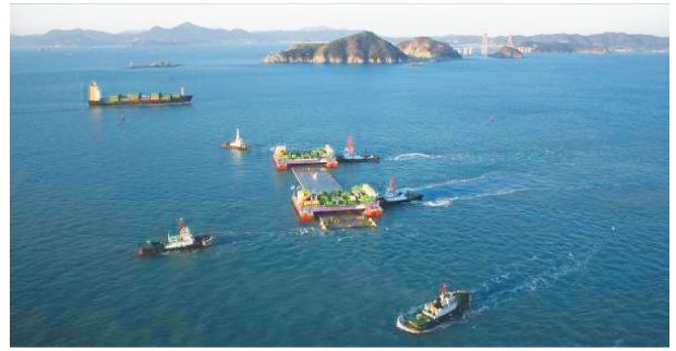
图 15 韩国釜山沉管管节的浮运沉放 (Mergor 照片)
