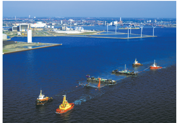
图 16 厄勒海峡通道首节沉管的浮运 (照片 ØresundsbronKonsortiet)
