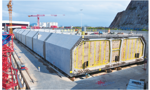
图 13 E22 管节整体长距离顶推施工完成 (叶常清摄)
