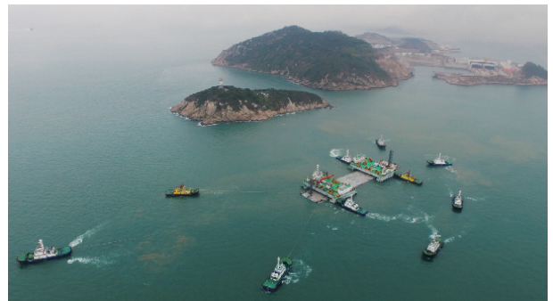
图 17 港珠澳大桥沉管 E30 管节的浮运 (薛安平, 陈立通 摄)
