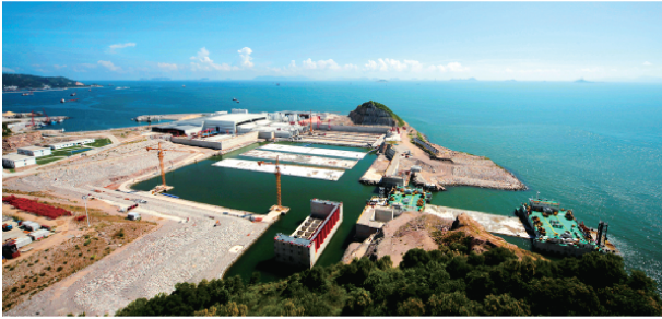
图 12 港珠澳大桥沉管预制厂、浅坞、深坞全景图 (港珠澳大桥管理局照片)
