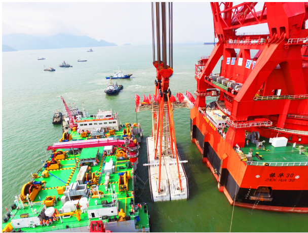
(a) 最终接头吊放入水
