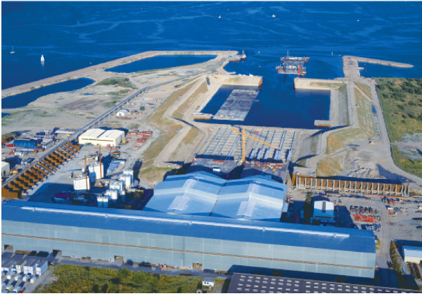
图 11 厄勒海峡通道沉管预制厂、浅坞、深坞全景图 (ØresundsbronKonsortiet 照片)
