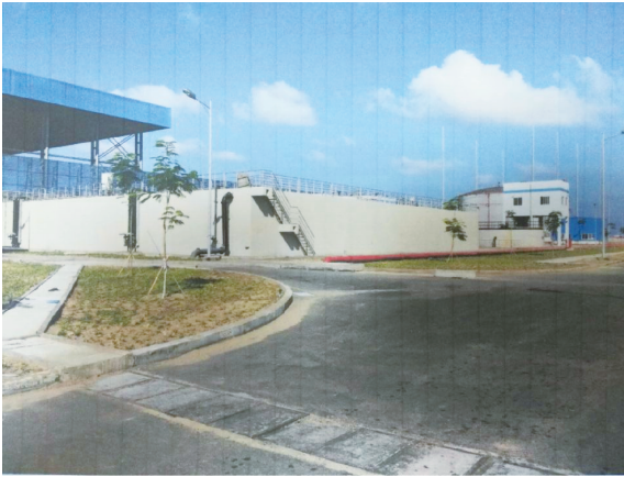
图2 水池裂缝表面修复后现场状况
