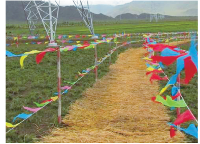
图 1 施工道路围栏及草垫隔离
