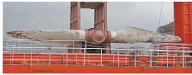
浙大650 kW机组海上安装
