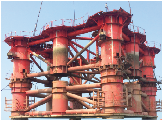
图6 海上超长钢管桩沉桩辅助导向架结构
