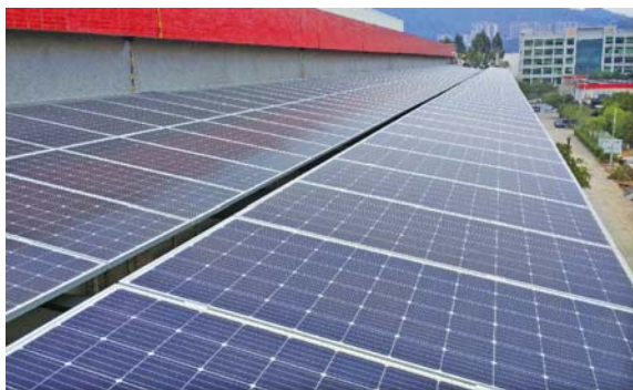
现场光伏系统安装实例
