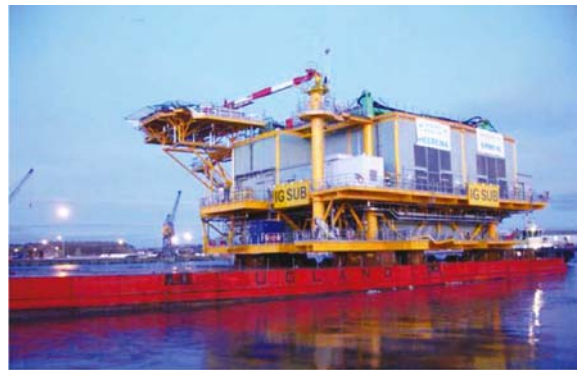
图 2 升压站整体运输图
