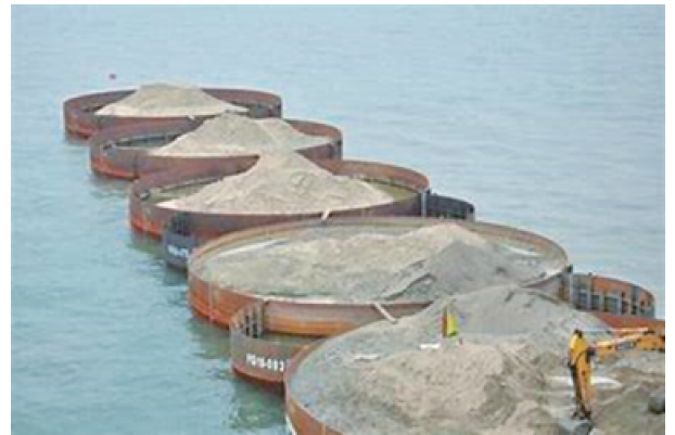
图 1 大直径格形钢板桩围堰实物图
