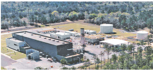
图5 美国阿拉巴马储能电站航拍照片
