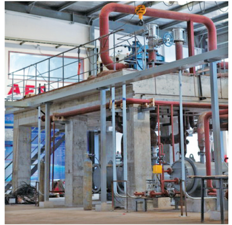
(c) 膨胀机组发电系统
