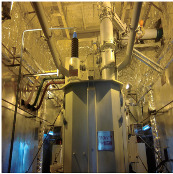
图9 主变低压侧管型母线连接方式
