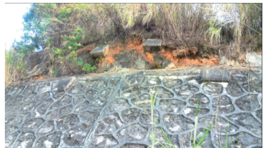
图 3 公路边坡支护概况
