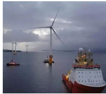
图 16 挪威 Hywind 样机项目 [62] Fig. 16 Hywind demo project in Norway
