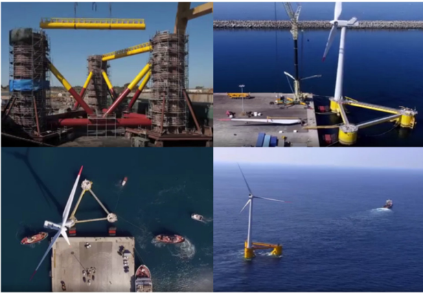
图 13 浮式风机建造、安装及运输 [54]
