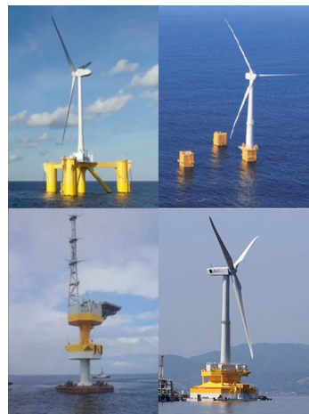
图 18 日本福岛试验项目 [64] Fig. 18 Floating wind turbines demo project in Fukushima, Japan
