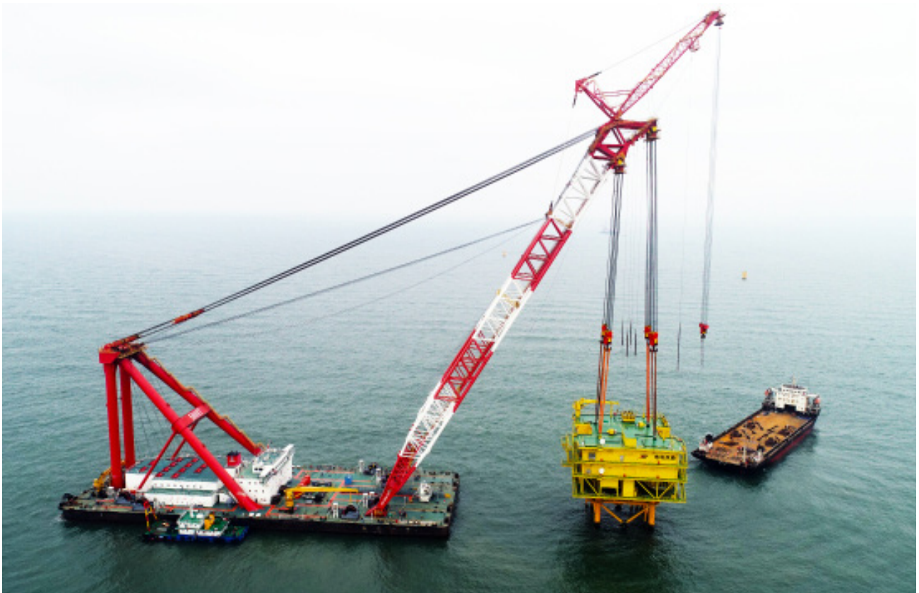
广东粤电湛江外罗海上风电项目海上升压站吊装成功
