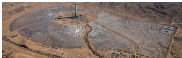
图4 以色列 Ashalim 塔式光热电站照片
