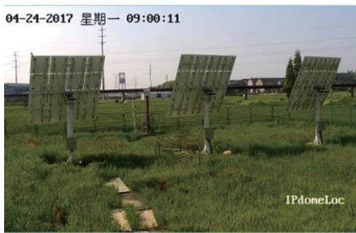
图2 塔式太阳能控制试验台测试实景图
