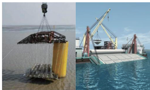
图8 砂被施工和连锁排施工
