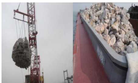
图7 网兜抛石和开口驳抛石施工
