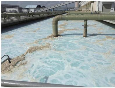
图4 曝气池内氧化风机曝气产生大量泡沫
