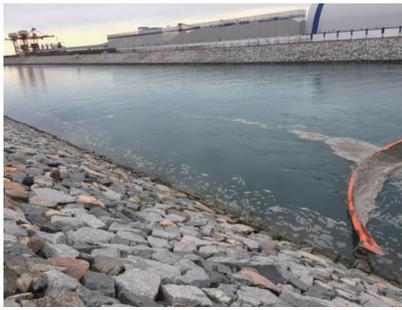
图9 拦泡网,把泡沫集中至排水明渠西侧集中喷淋点2
