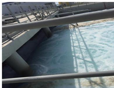
图3 曝气池出口至排水明渠设置挡水墙,海水翻滚
