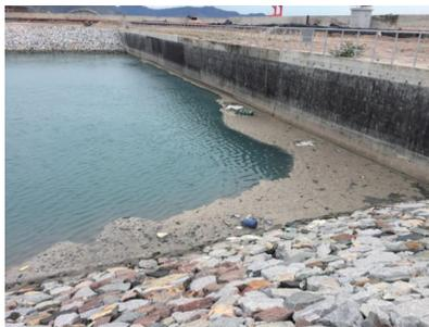
图6 排水明渠出水口还聚集大量泡沫
