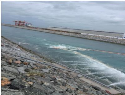
图10 在排水明渠西侧集中喷淋点2喷淋消泡,泡沫几乎消除,表面看不到泡沫
