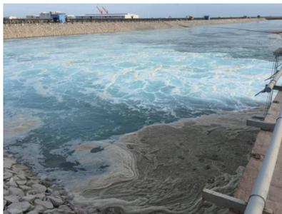
图5 排水明渠进水口水流湍急,形成大量泡沫
