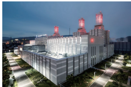
图1 北京京西燃机热电厂
