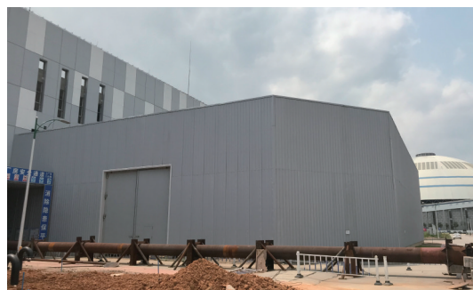
图13 变压器区隔声屏障
