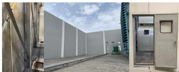
图12 室内降噪墙体、屋面降噪墙体、设备降噪外壳 (从左到右)
