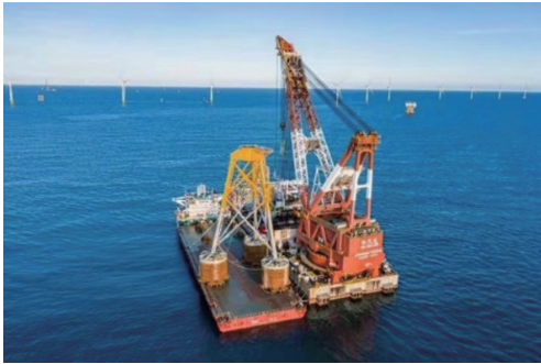
图1 某海上风电三筒导管架基础
