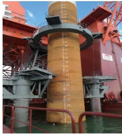
图1 调整钢管桩中心坐标和垂直度
