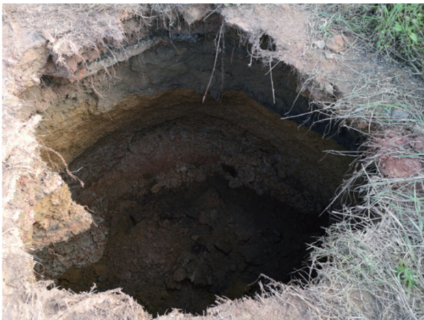
图1 某场址钻探完成后塌陷现场照片
