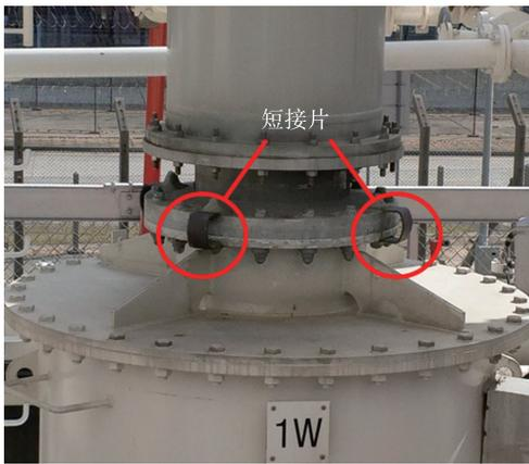
图9 跨接后变压器升高座法兰处
