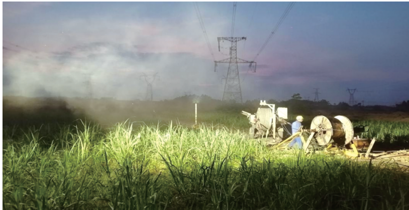
现场更换场景
