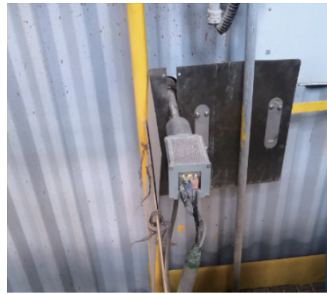
图7 温度场探头安装位置及实景图
