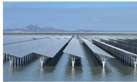
图1 正泰 550 MW 海洋光伏电站桩基支撑结构
