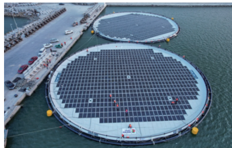
图 7 500 kW 漂浮式海上光伏项目环形浮体单元
