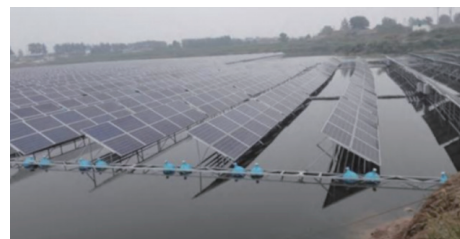
图2 浮管式漂浮光伏电站
