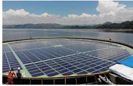
图 5 MAGAT 项目漂浮式光伏系统
