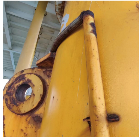
图10 电偶腐蚀现象
