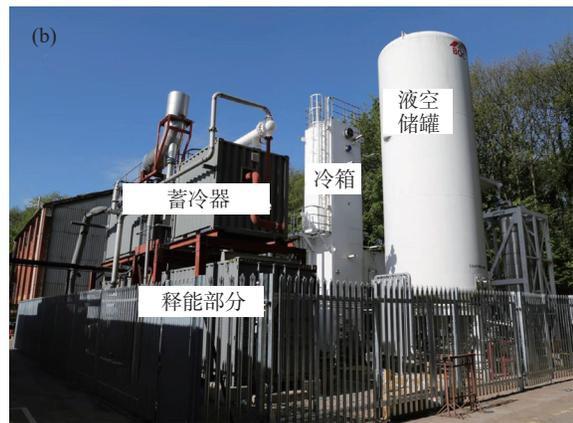
图 1 LAES 中试装置的流程图 (a)<sup>[19]</sup> 和现场照片 (b)<sup>[11]</sup>
