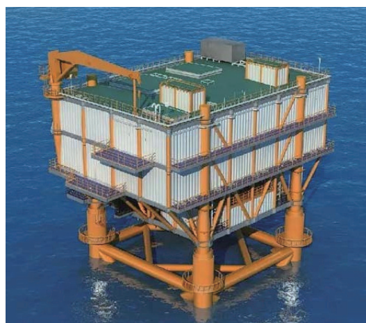
图1 整体式海上升压站结构图
