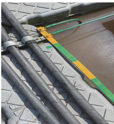
图 7 镀锌扁钢刷漆使用
