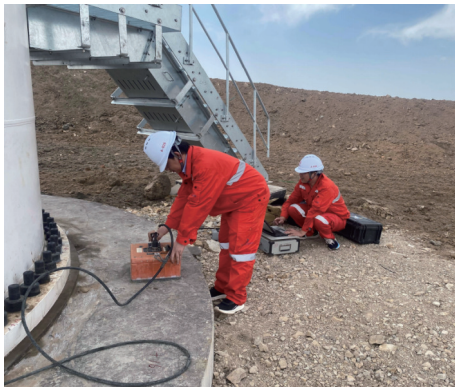
图 3 地质雷达现场检测
