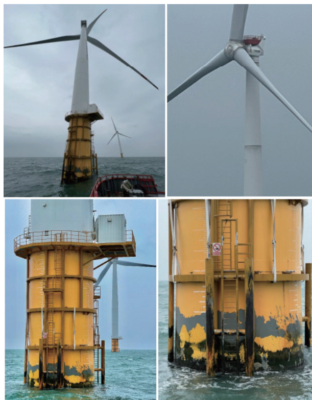
图 2 海上风电机组腐蚀示意图
