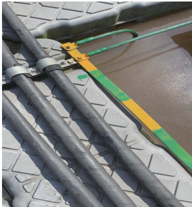
图 7 镀锌扁钢刷漆使用
